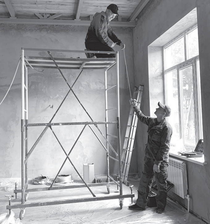
Монтажно-строительные работы идут полным ходом
